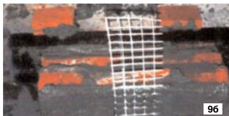
Рис. 9. Изготовление образцов для проведения испытаний на вырыв связи из кладки
