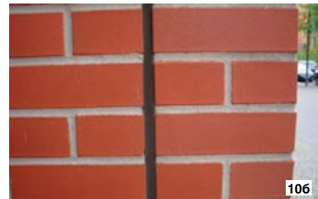
Рис. 10: а, б — вертикальные деформационные швы в лицевом кирпичном слое на углу здания, Берлин; в, г — трещины в лицевом слое на углу здания вследствие отсутствия там вертикальных деформационных швов; д, е — ремонт отслоившейся кладки на углу здания (ул. Магнитогорская, 2006 г.)
