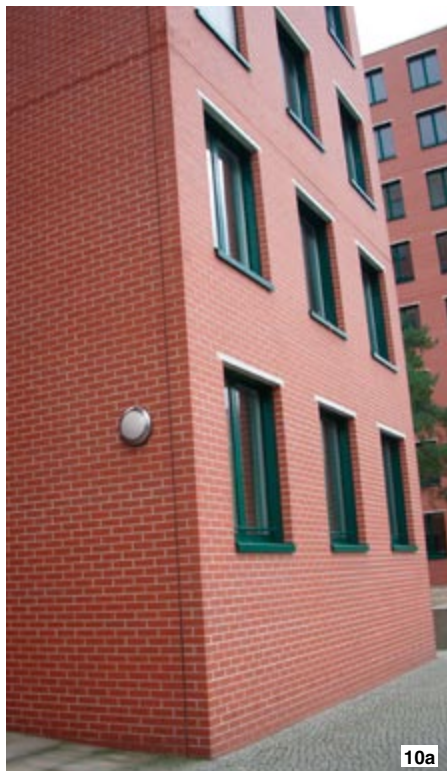
Рис. 10: а, б — вертикальные деформационные швы в лицевом кирпичном слое на углу здания, Берлин; в, г — трещины в лицевом слое на углу здания вследствие отсутствия там вертикальных деформационных швов; д, е — ремонт отслоившейся кладки на углу здания (ул. Магнитогорская, 2006 г.)
