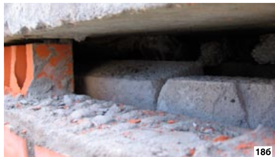
Рис. 18. Зазор между низом плиты перекрытия и утеплителем (ул. Петрозаводская, 2007 г.)
