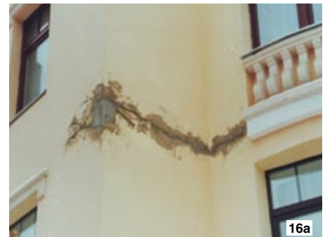
Рис. 11. Некачественное исполнение горизонтального деформационного шва на доме (ул. Петрозаводская, 2007 г.)
