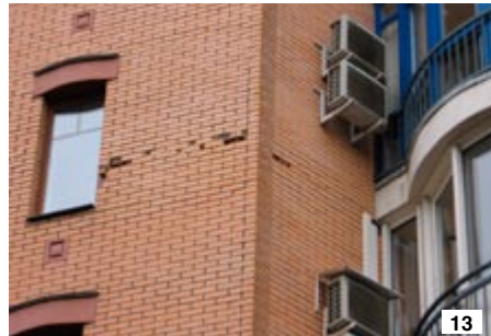
Рис. 11. Некачественное исполнение горизонтального деформационного шва на доме (ул. Петрозаводская, 2007 г.)
