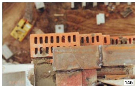
Рис. 14. Смещение кирпичей лицевого слоя с опорного стального уголка на 8–10 см (ул. Молодогвардейская, 1989 г.)
