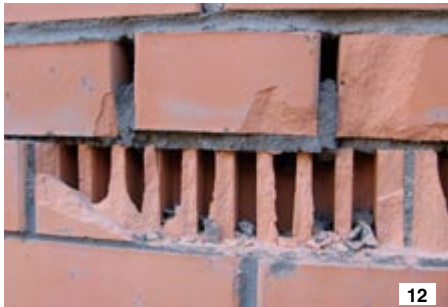
Рис. 11. Некачественное исполнение горизонтального деформационного шва на доме (ул. Петрозаводская, 2007 г.)
