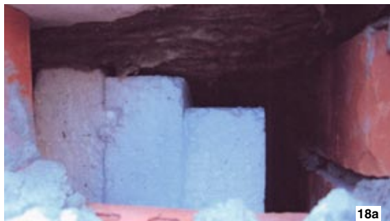
Рис. 18. Зазор между низом плиты перекрытия и утеплителем (ул. Петрозаводская, 2007 г.)
