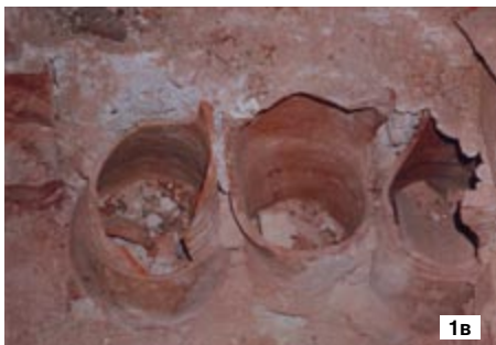
Рис. 1. Керамические элементы для кладки забутовки стен (б) и пазух сводов (в) Большого Кремлёвского дворца (а)
