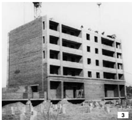
Рис. 3. Строительство первого в России экспериментального жилого дома высотой 10 этажей с наружными стенами из трехслойной облегченной кладки с соединением слоев вертикальными кирпичными диафрагмами, г. Воскресенск, 1993 г.
