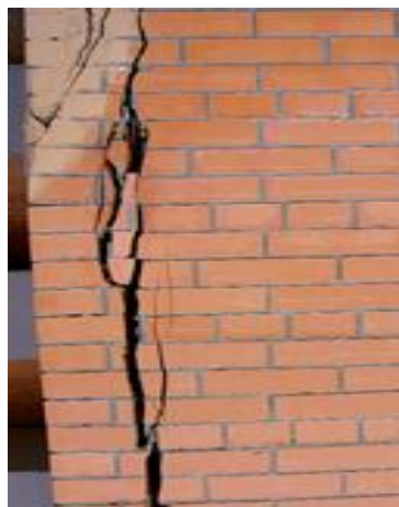
Рисунок 9– Трещины в кладке лицевого слоя, возникшие от температурно-влажностных деформаций на углу здания (а) и на удалении от угла здания (б)
