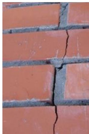
Рисунок 9– Трещины в кладке лицевого слоя, возникшие от температурно-влажностных деформаций на углу здания (а) и на удалении от угла здания (б)
